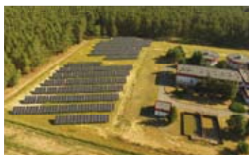
Montaż i uruchomienie małej instalacji odnawialnego źródła energii o mocy 489,39 kWp
